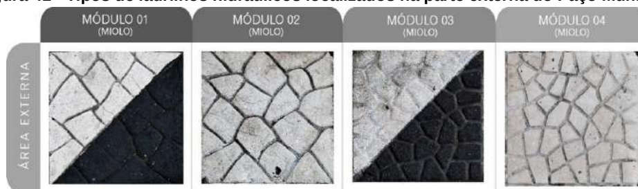
Figura 41 - Tipos de ladrilhos hidráulicos localizados na parte externa do Paço Municipal
