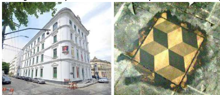
Figura 19 – Paço do Frevo e ladrilho em processo de intervenção
