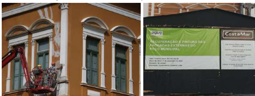
Figura 72 – Fachadas do Paço sendo restauradas
