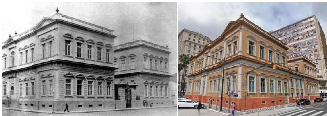
Figura 67 - Fotografias retratando as modificações feitas na fachada dos fundos do Paço
